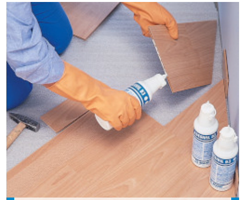
Collage avec Adesivil D3 en rainure de languette
