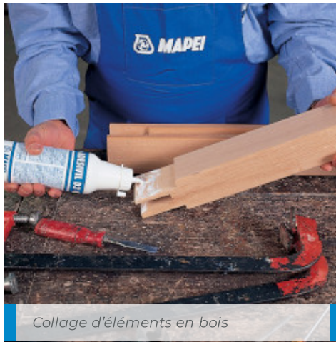
Collage avec Adesivil D3 en rainure de languette
