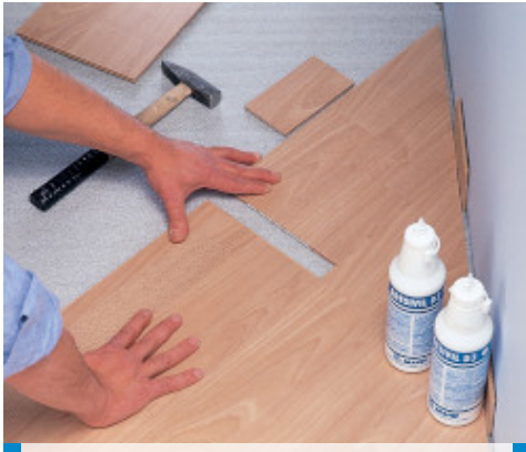
Positionnement de la lame rainurée bouvetée
