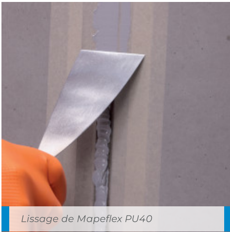
Élimination du ruban adhésif disposé pour éviter les bavures
