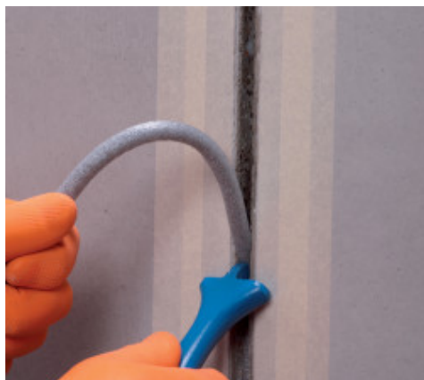
Insertion du fond de joint MAPEFOAM
